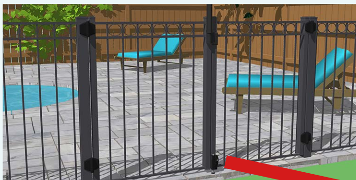
Exemple de portière double dont l'une des deux portes est maintenue en position fermée au moyen d'une barrure à clé. L'autre porte se referme et se verrouille automatiquement.
